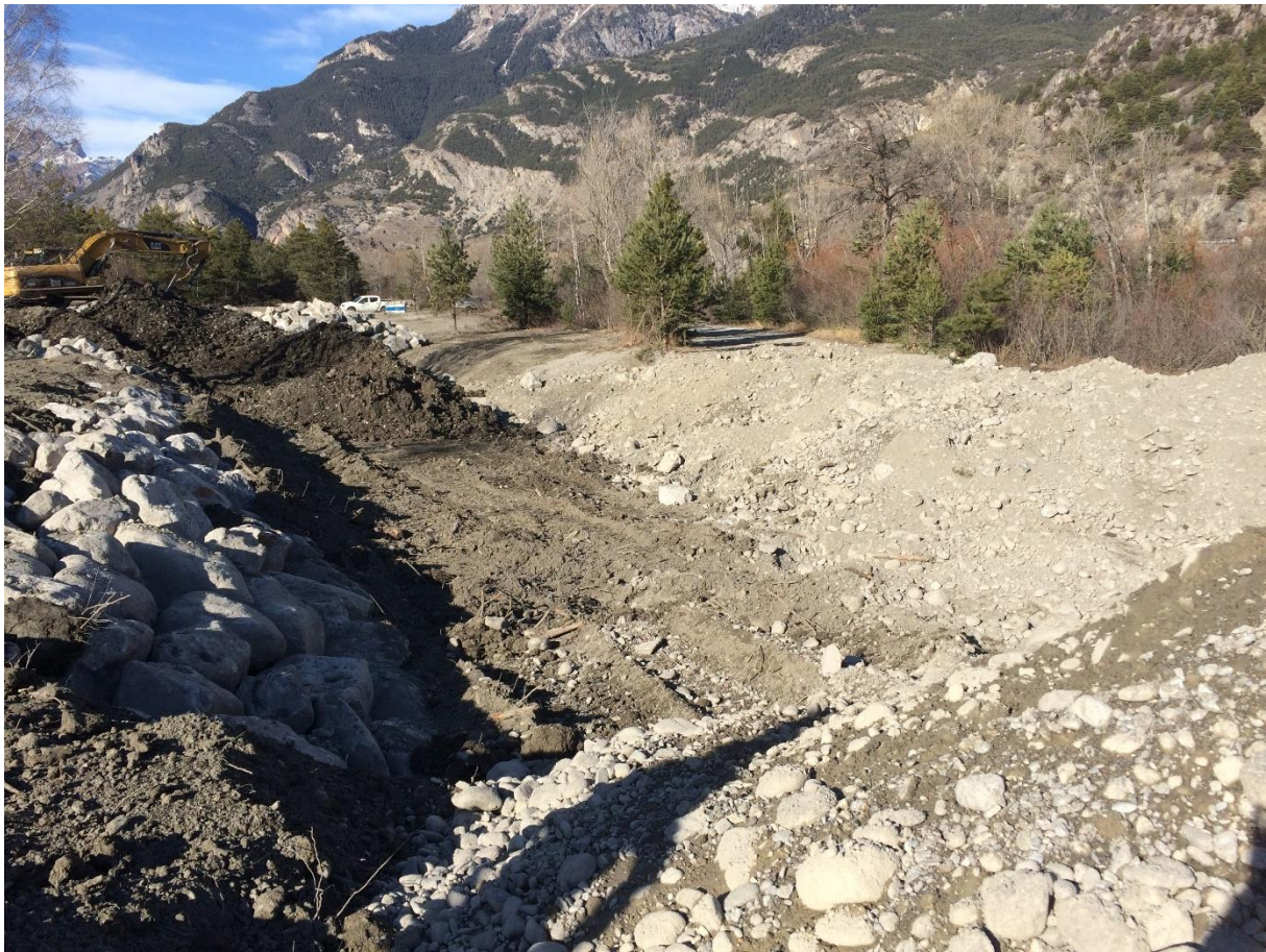
5 Préparation de la couche de fond en nite (zone nord)
