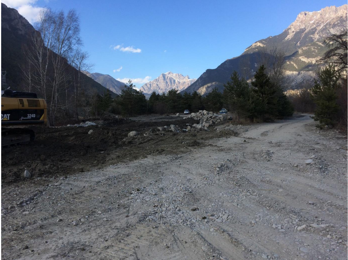
7 Détail du passage de la piste d'accès
