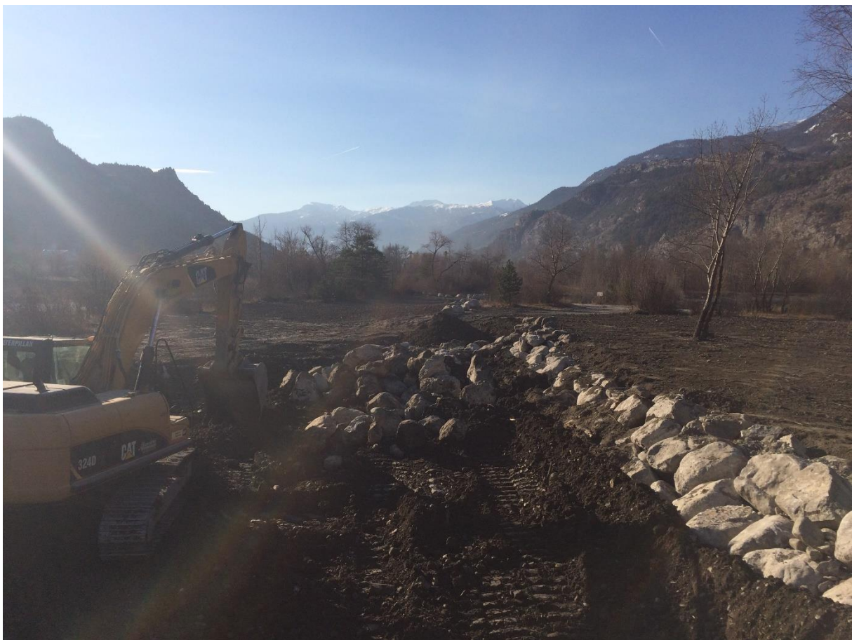
6 Pose de la dernière couche de blocs (zone nord)
