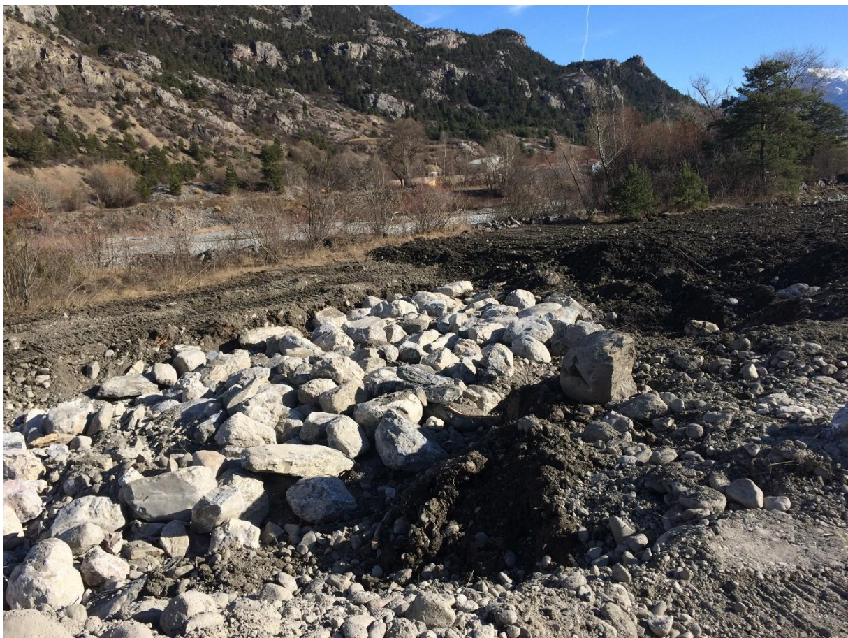
4 Couche de blocs terminé avec la dernière couche de finition (zone centrale)
