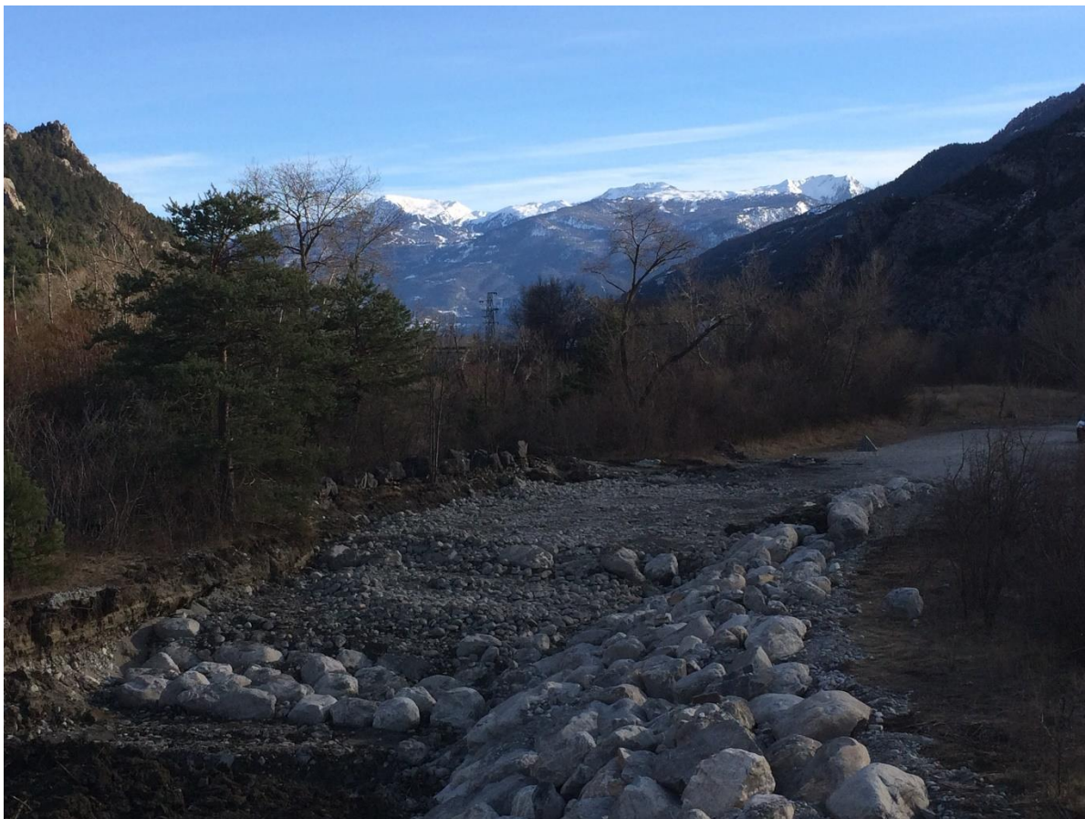
1 Remblaiement par couche zone sud
