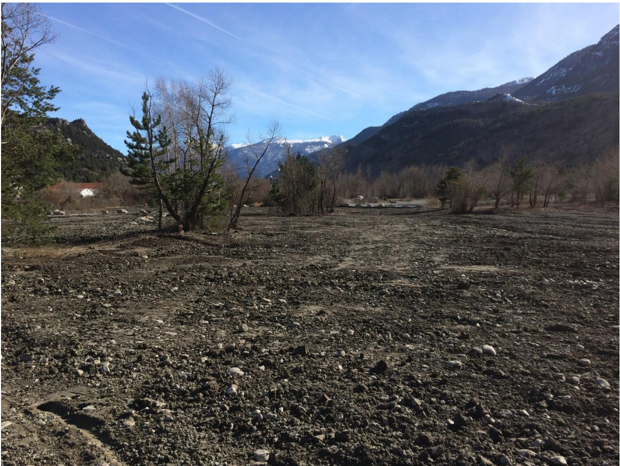
10 Détail des finitions des zones de stockage et pose des blocs pour barrer le passage
