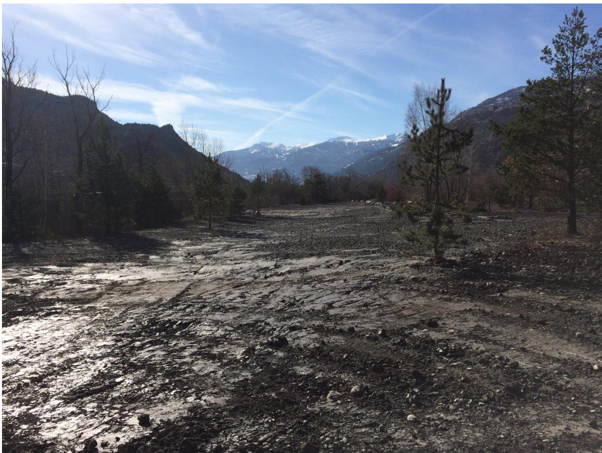
12 Vue sur la totalité de l'ouvrage terminé
