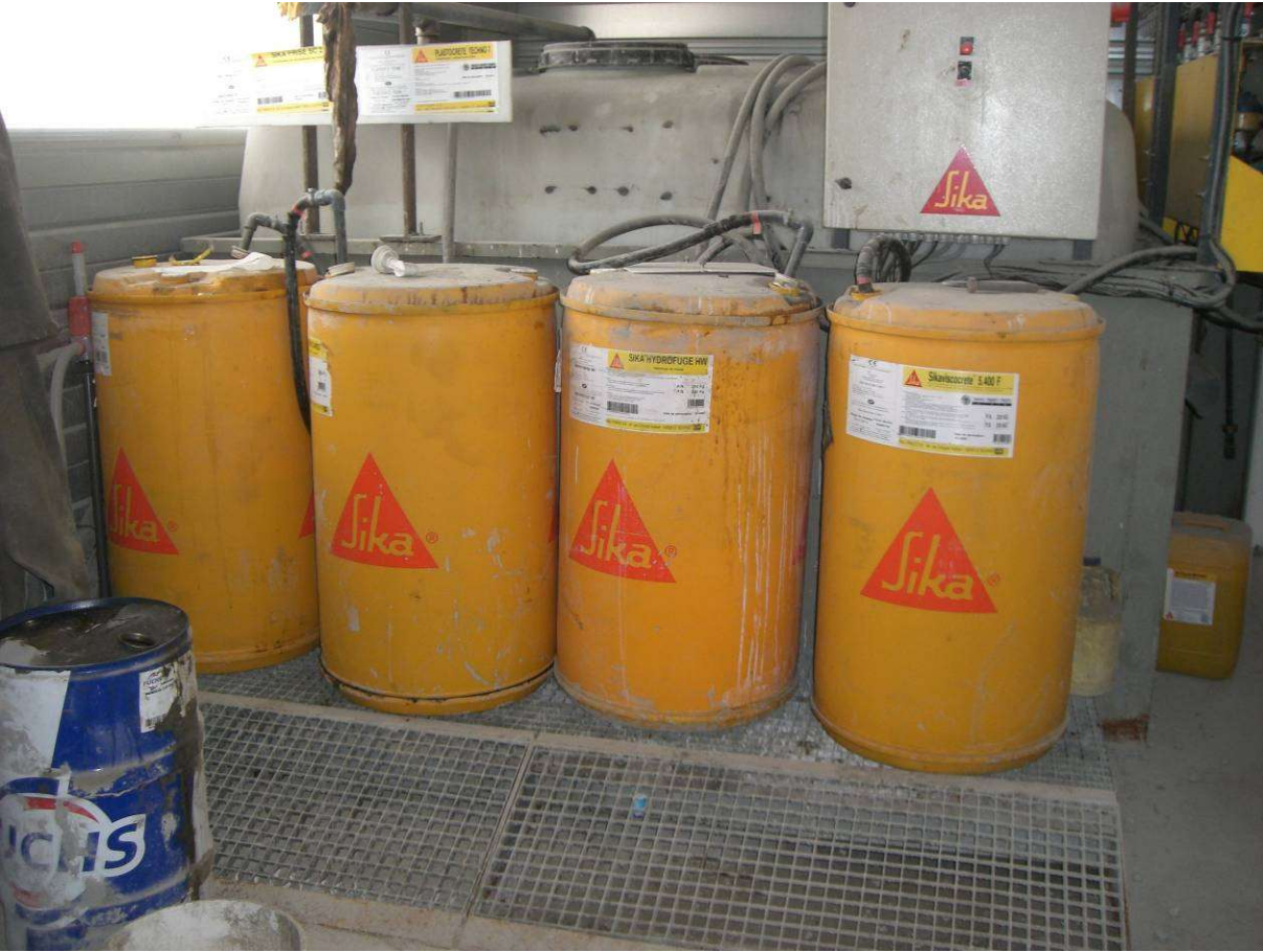
Stockage des produits de la centrale à béton à l'intérieur de la structure bardée
