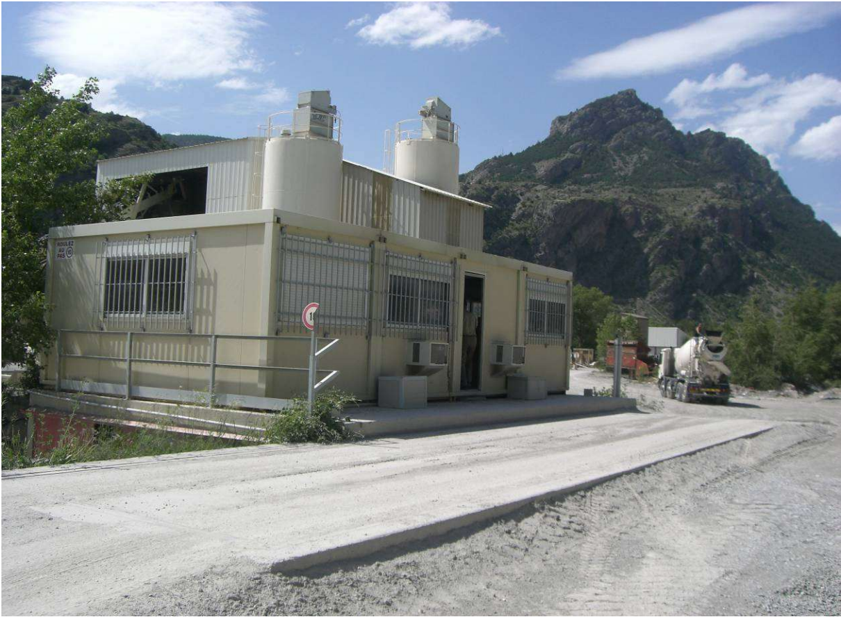
Pont bascule à la sortie du site
