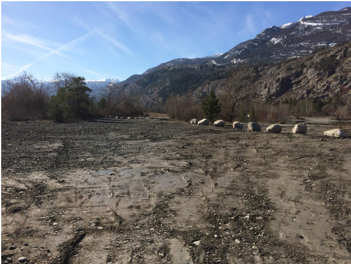
11 Finition de la zone sud et détail de la pose de blocs pour barrer le passage de l'ouvrage
