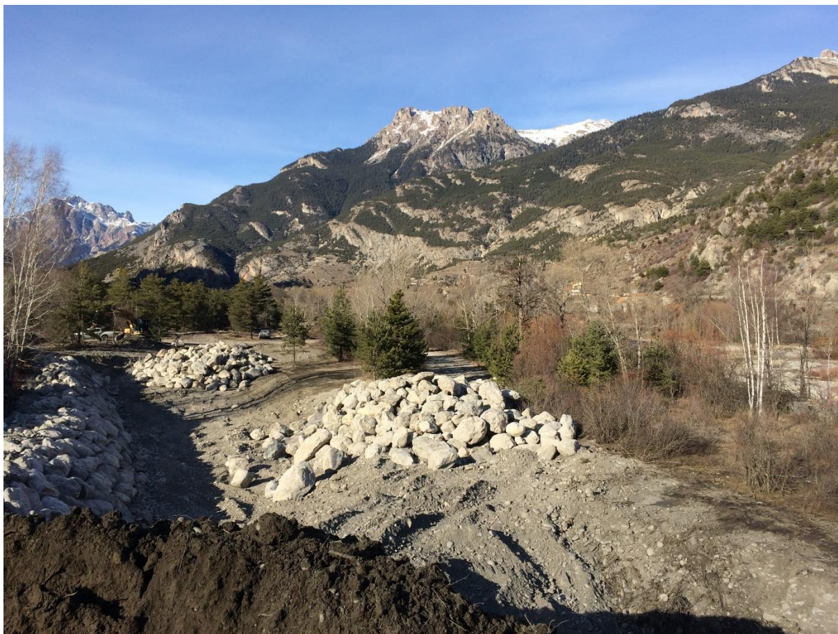
2 Stockage des blocs utilisés pour le remblaiement
