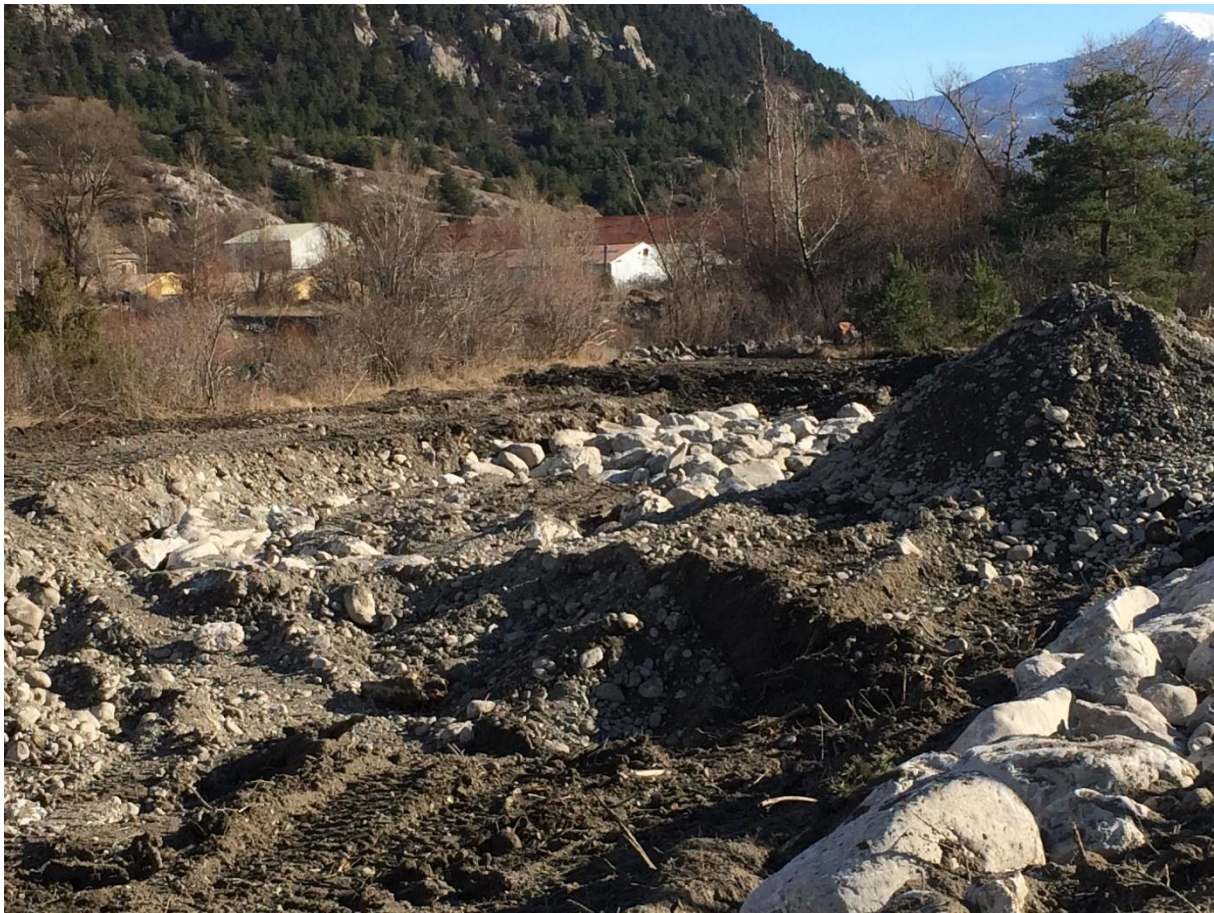
3 Pose de la couche de blocs (zone centrale)
