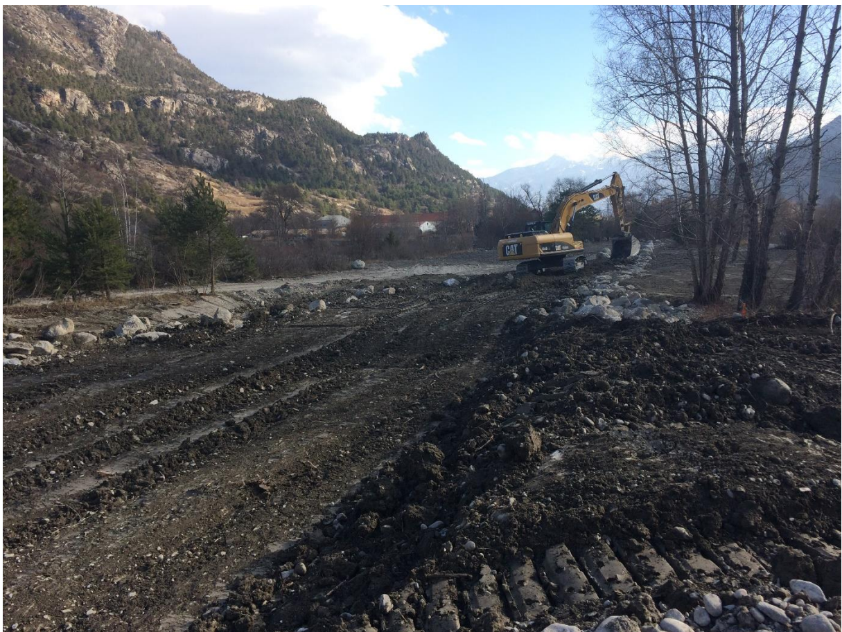
8 Mise en œuvre de la dernière couche de matériaux (zone nord)
